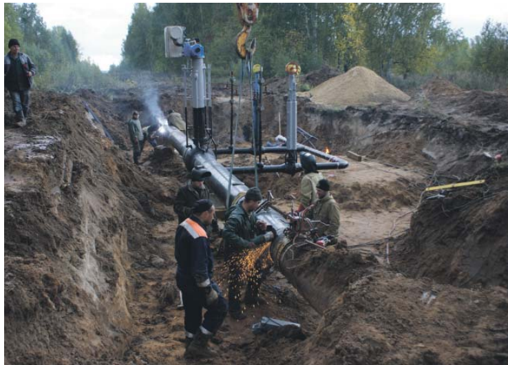
Летом текущего года газозаводы начали капитальный ремонт двух линейных участков газопроводов Казань – Нижний Новгород и Миннибаево – Ижевск
